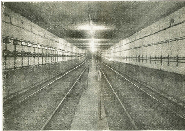
Abb. 5 Blick in die normale Tunnelstrecke.
