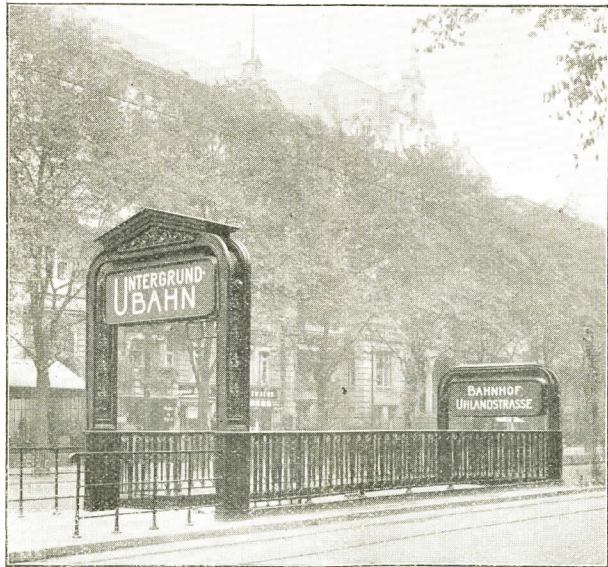
Abb. 12 Ein etwas einfacher ausgestatteter Eingang.
