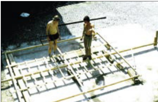
Bau des ersten Floßes an der Bäumenstraße. Heute steht dort das City Center.
