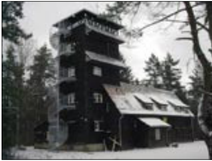
2001, aufgrund der verschärften feuerpolizeilichen Bestimmungen, musste ein Fluchtweg aus den Turmzimmern geschaffen werden. Wegen des engen Treppenhauses war dies nur von außen möglich. Kosten über 40.000 DM. Auch die 1991 angebrachten Sonnenkollektoren sind gut zu erkennen.
