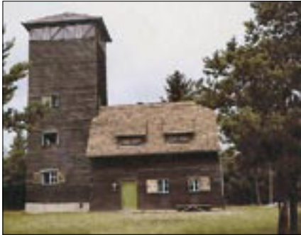
1958, der „Kleine Feuerstein“, wie er zuvor hieß, fast noch im „Urzustand“. Das Dach auf dem Turm und die Verglasung gab es vorher nicht. Der Turm war zuvor mit Zinkblech abgedeckt.
