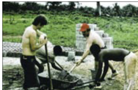
Auf der Baustelle in Porto Novo. Mit roter Mütze Hans Klein aus Höchststadt.
