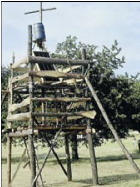
WöSoLa 1990. Dem Ökobauern will man nicht nachstehen. Daher Warmwasser durch Solarenergie.
