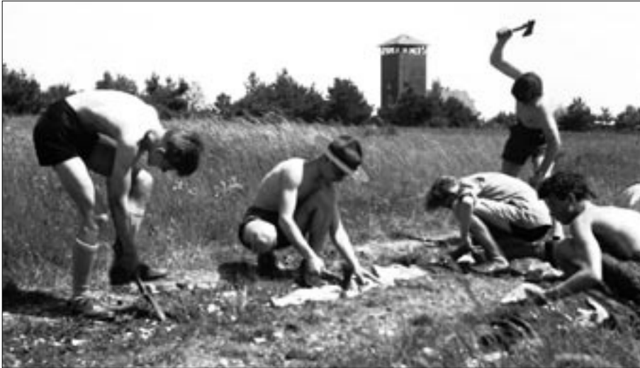
Georgschild, Sippe Habicht beim Straßenbau, mit einfachsten Mitteln, 17 m auf dem Weg zum Lindersberg
