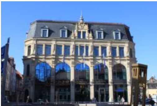
Ein Highlight des Jahres: Renovierung des ehemaligen Kaufhauses Kohlenmarkt 4. Dank an die Raiffeisen-Volksbank Fürth, an deren Vorstände Thomas Gimperlein und Markus Engelmayer und an Architekt Stephan Zechmeister.
