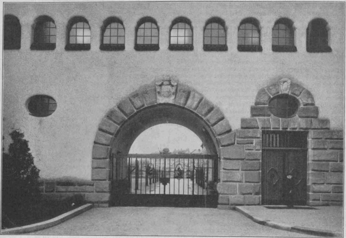
Schulhaus an der Frauen-Straße. Einfahrt und Eingang an der Frauen-Straße.
