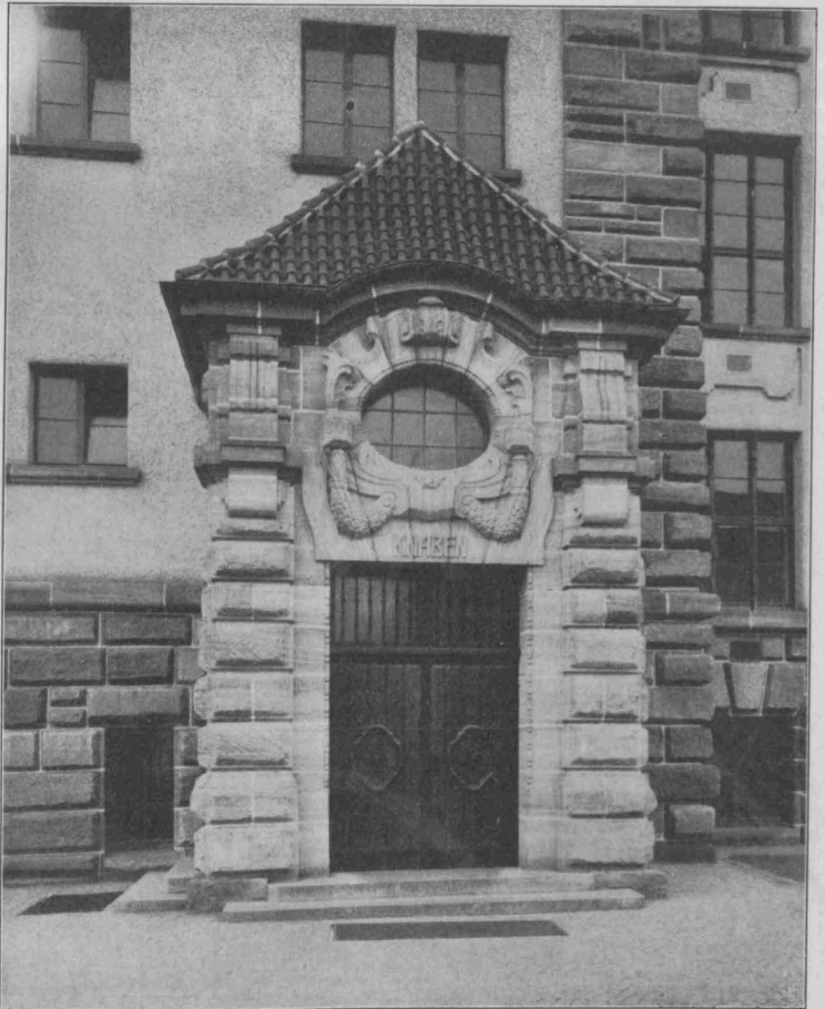
Schulhaus an der Frauen-Straße. — Knabeneingang.
