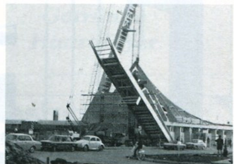
Foto vom Bau der Kirche. Ein schwerer Lastkran hievt gerade einen der beiden Teile des Turmes nach oben.
