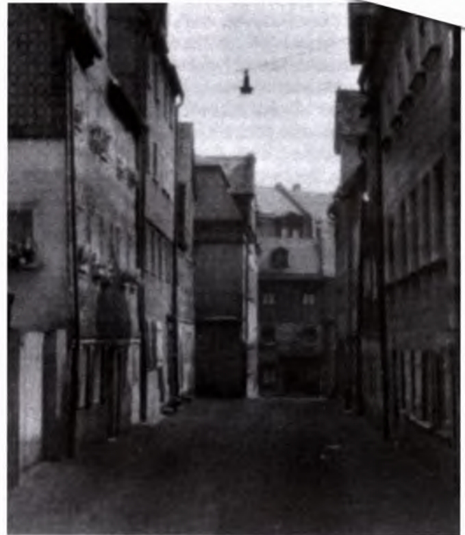
Schindelgasse – immer noch asphaltgeschädigt (Repro AB 4/1977)
