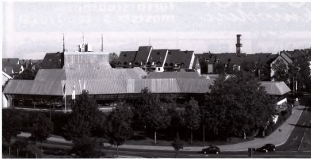
Die moderne Halle von Südwesten.
