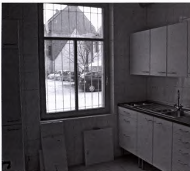
Neue Küche kurz vor der Fertigstellung 2006. (Foto: HR)
