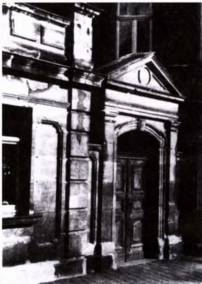
Portal zu Waagstraße 5 (Repro Ab 20/1985)
