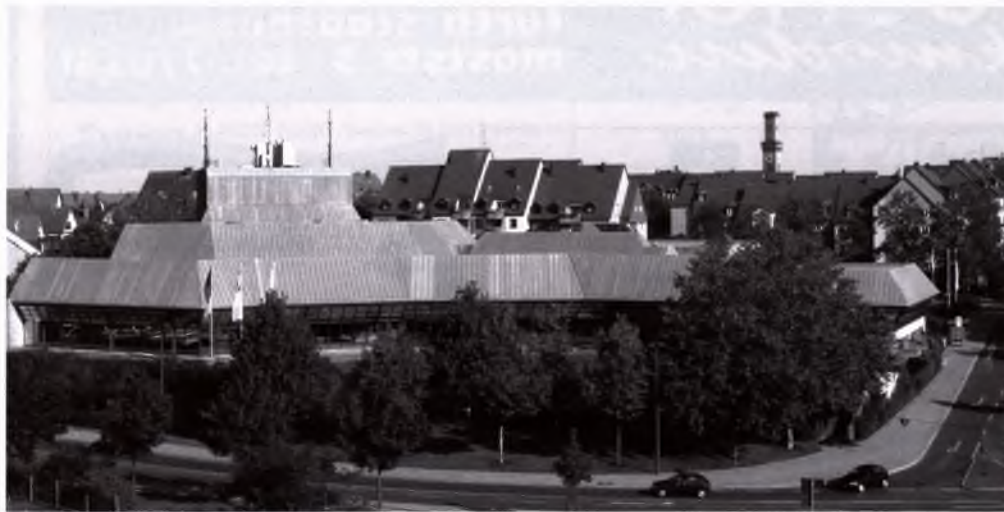
Die moderne Halle von Südwesten.
