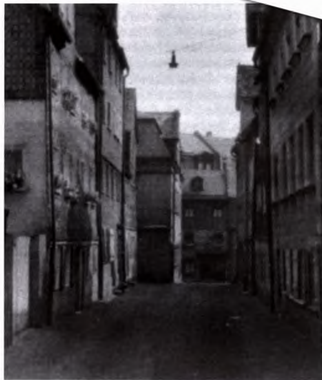
Schindelgasse – immer noch asphaltgeschädigt (Repro AB 4/1977)
