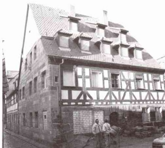
Diese beiden Häuser wurden auch mit Hilfe der BVgg. saniert
