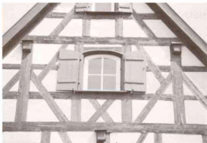
Fachwerkdetail mit K-Streben und einem Andreaskreuz am Pfarrhof (um 1700), Foto: H.-G. Ohm
