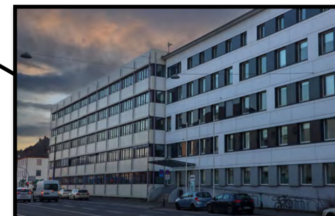
Ämtergebäude Süd Schwabacher Straße 170, 90763 Fürth
