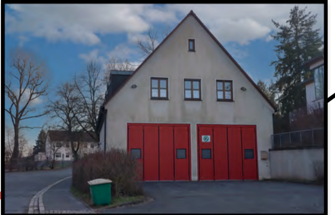
Feuerwehrrätehaus Burgfarnbach Regelsbacher Straße 78, 90768 Fürth
