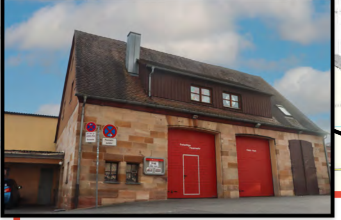
Feuerwehrrätehaus Vach Rotdornstraße 3, 90768 Fürth
